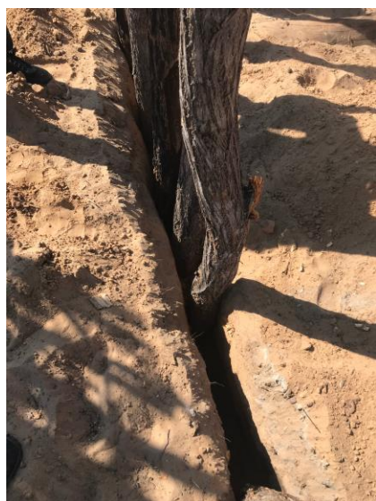
Figure 12 : Enclos à chèvres en cours de construction à Ntubya - enterrement des troncs à 60 cm
