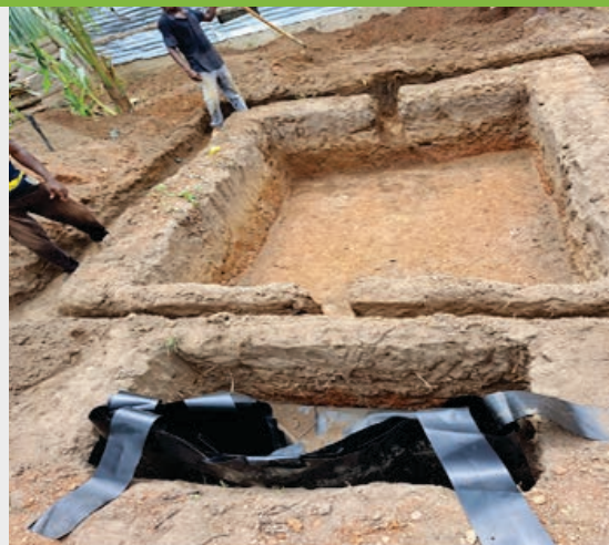
Fosse pour biodigesteur
