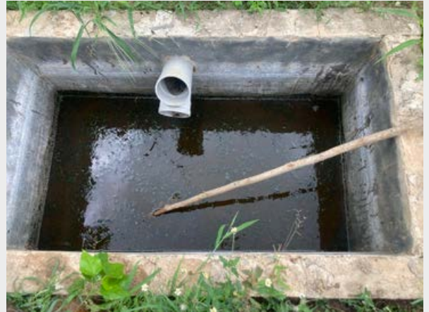
Fosse pour digestat liquide
